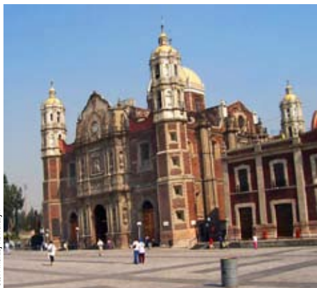
↑ Szesnastowieczna katedra w Mexico City przechylona na skutek osiadania gruntu
